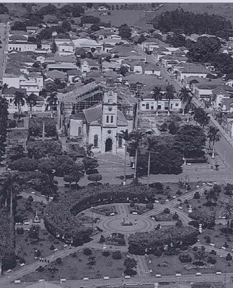
Foto aérea da fachada da Igreja Matriz, quando já começava a construção, na parte posterior, da nova igreja, do acervo Abe Fotos, sem data.
