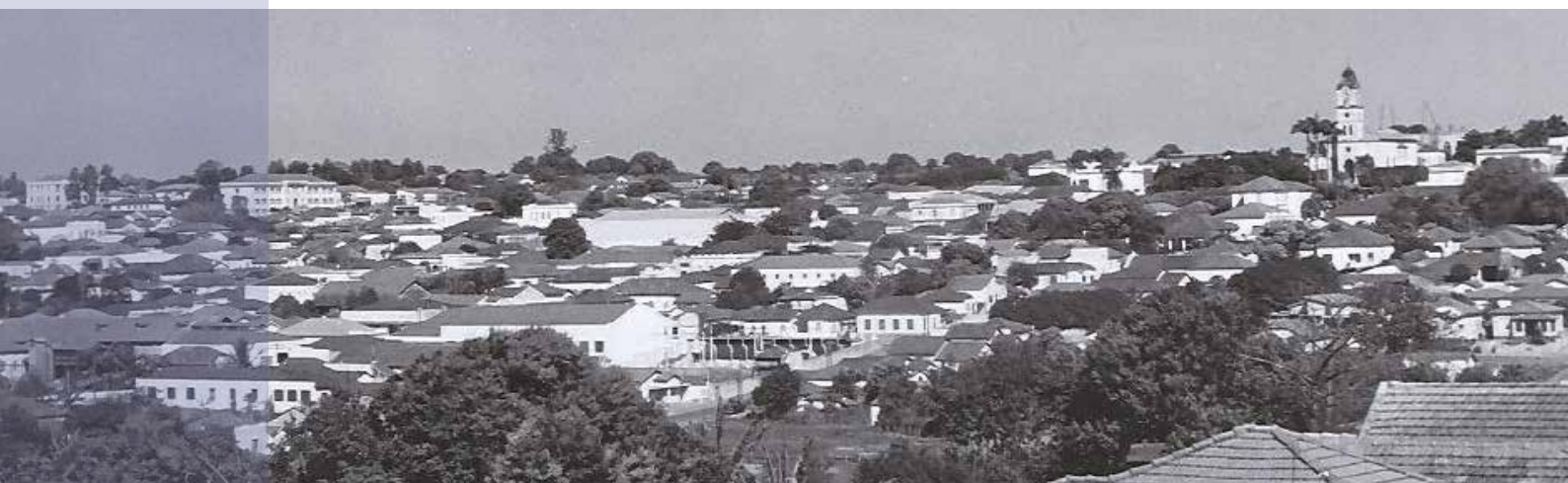
Foto panorâmica da cidade com a torre da Igreja Matriz em destaque no lado direito. As obras da nova igreja já haviam começado. Do acervo Abe Fotos, sem data.
